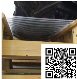
Die biaxial gereckten Ondex Super HR Lichtplatten werden vom Hauptverband der deutschen Berufsgenossenschaften auch nach 25 Jahren Freibewitterung noch als durchsturzsicher eingestuft.
