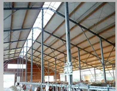
Müller Licht- und Lüftungsfirste
